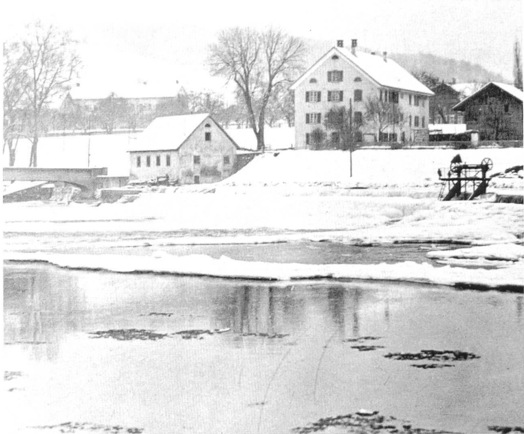
Die alte Reussmühle auf der Gebenstorfer Seite. Aufnahme zur Zeit der grossen Gfrörni von 1929.
