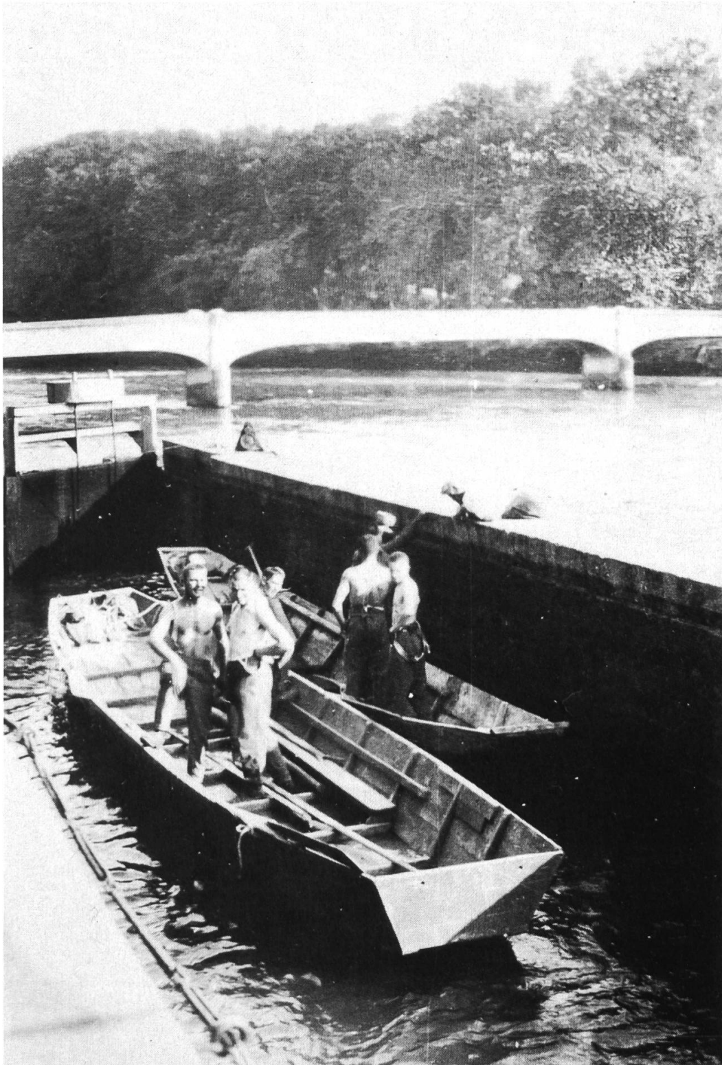
Die Kammerschleuse nach den Revisionsarbeiten von 1919. Die im Text erwähnten Ketten sind heute noch vorhanden.
